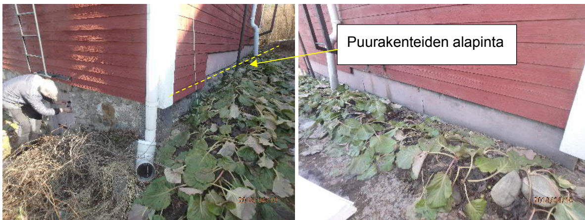
Kuva 1. Puurakenteiden alkuperäinen taso leikkaa nykyisen maanpinnan tason alapuolelle keittiön kohdalla. Seinän alaosan rakenteita on todennäköisesti korjattu uusimman laajennusosan tekemisen yhteydessä, koska asbestisementtilevysokkeli jatkui ulkonäöllisesti yhtenäisenä.
