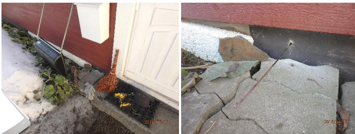
Kuva 2. Asbestisementtilevyrakennetta tutkittiin pesuhuoneen kohdalta tutkimusporauksella. Maanpinnan alapuolelta lähtevän levyn takana oli puukoolaus ja mineraalivillaa yhteensä noin 120 mm. Sen takana havaittiin betonipinta.
