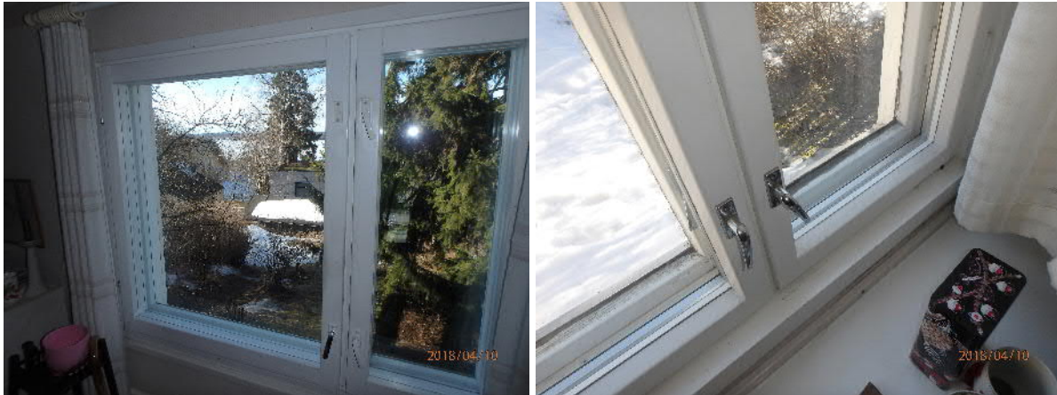
Kuva 5. Vasemmalla kamarin uusittu ikkuna ja oikealla lisälasilla varustettu keittiön ikkuna.
